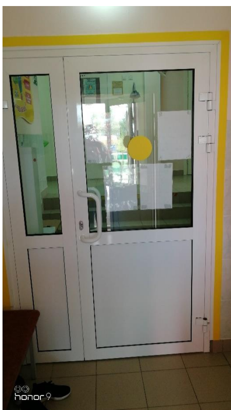
Фото №8. Вход. Тамбур.
