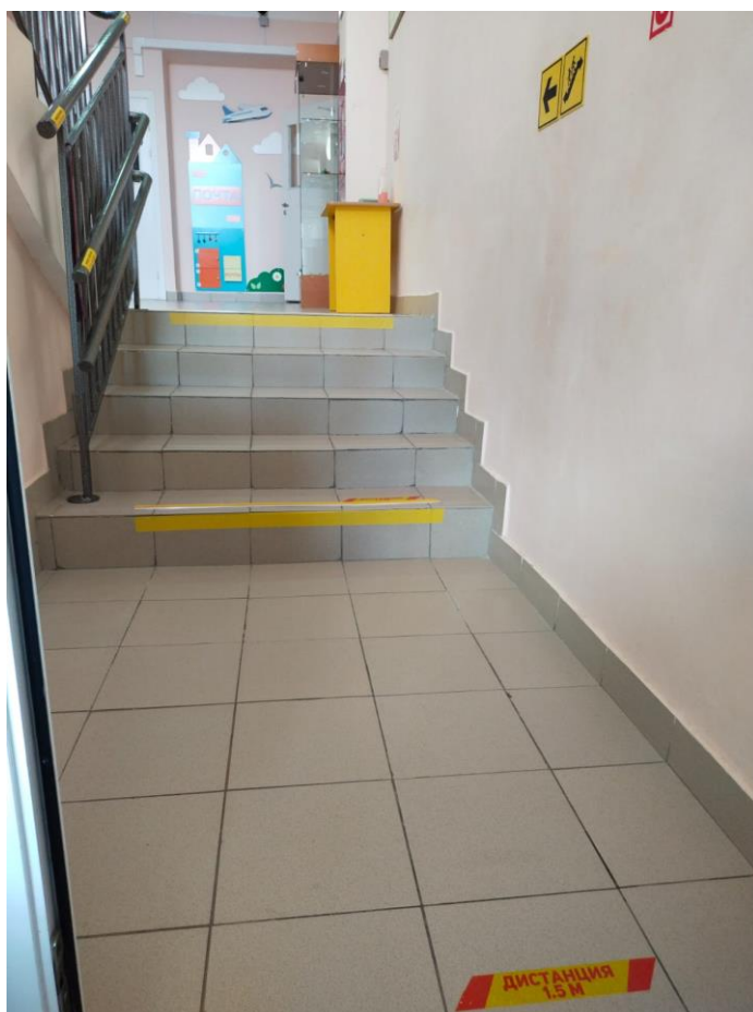
Фото № 12. Лестница со стороны эвакуационного выхода
