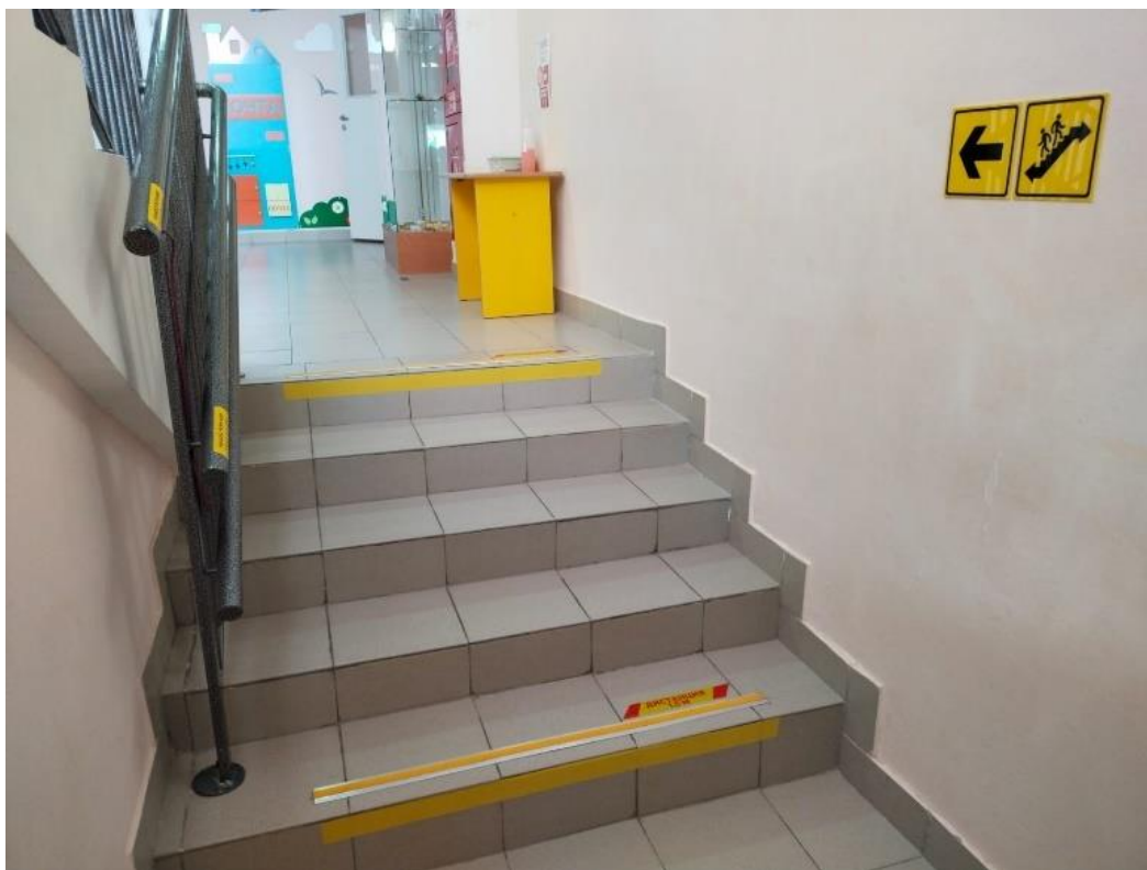
Фото №13. Лестница со стороны эвакуационного выхода
