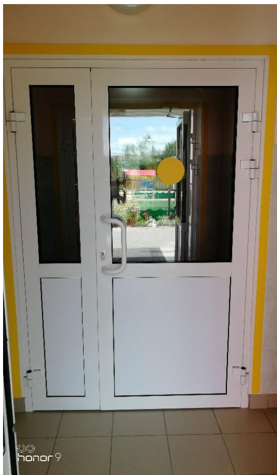
фото № 11. Эвакуационный выход
